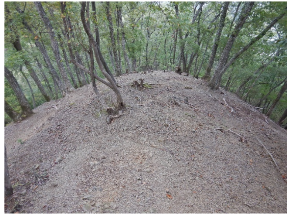
平坦な尾根部や緩傾斜の斜面では下層植生及び落葉層がほとんどなく、表土（落葉層）の消失が各所でみられる
