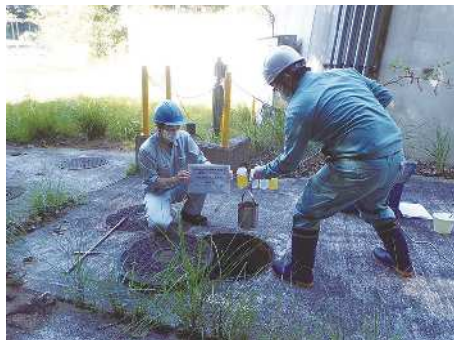
下水道放流水調査
