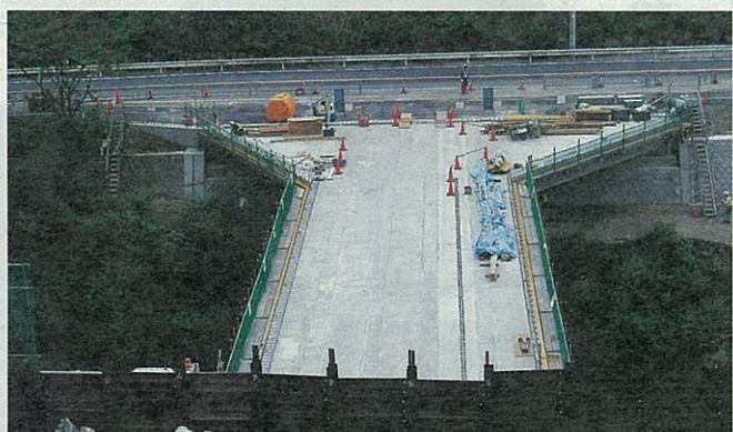
【橋の長さ 35.7m 幅 10m 片側歩道付2車線】
