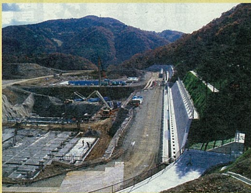
3 焼却施設棟工事状況
