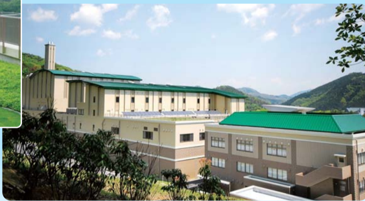
西側から施設を望む
