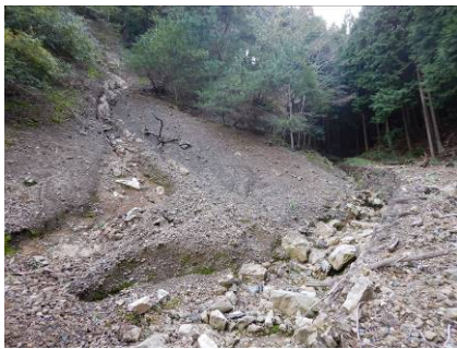
斜面崩壊地の沢筋
