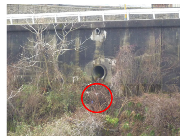
東側雨水採水地点(河川放流手前)
